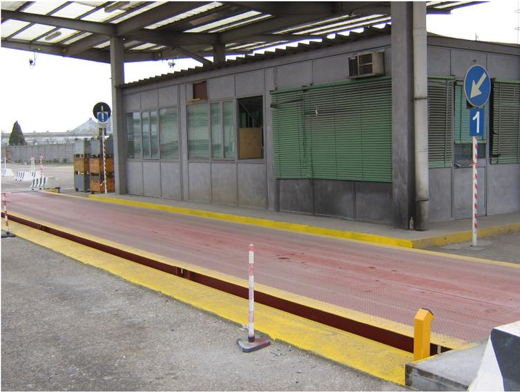
VISTA LATERALE DELLA BILANCIA E DELLA GUARDIOLA NELLA QUALE E' POSTO L'APPARATO ELETTRONICO DI LETTURA DEL PESO
