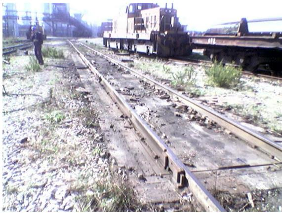
**VISTA DELLE DUE PIATTAFORME ,LE CUI LUNGHEZZE DI MT 12,5 E 7,5 CON UN INTERASSE DI MT 0,5,PERMETTONO LA PESATURA DI TUTTI I VAGONI ESISTENTI SULLA RETE FERROVIARIA**
