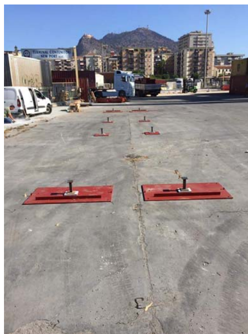
Fissaggio delle piastre di fondazione
