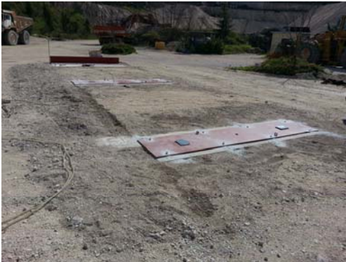
Montaggio delle piastre sulle basi in cemento
