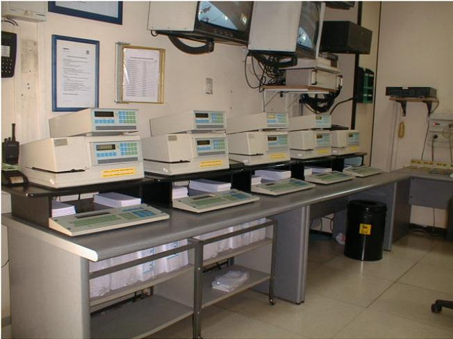
Vista del pulpito di controllo e dei terminali di pesatura delle cinque pesa a ponte
