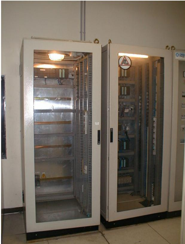
Armadio contenente i i dispositivi elettrici di comando delle elettrovalvole di erogazione del Gas e degli additivi
