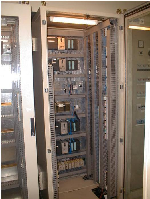
Vista dell'armadio che racchiude i PLC di controllo delle automazioni
