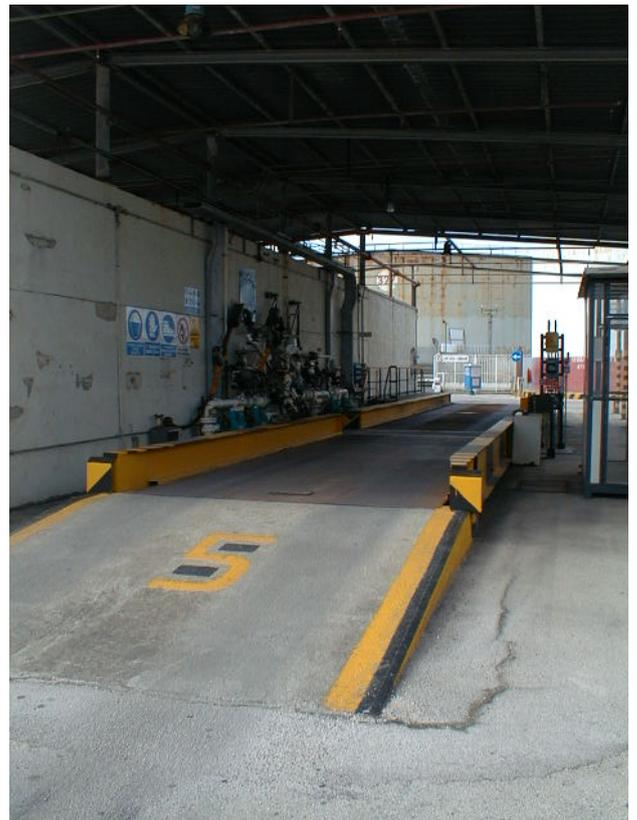
Pesa a ponte sopraelevata realizzata con doppia piattaforma per la pesatura indipendente della motrice e del rimorchio delle autocisterne.
